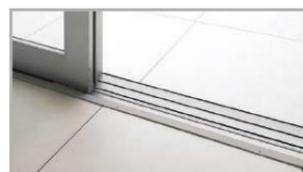
FIXフレームレス構造
