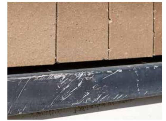
1階の基礎部では、荷運びの際に壁面を擦ってしまい、水切り部材の塗装が剥げ、擦り傷が残ってしまいましたが、タイル面は目立ったキズはついていません。
